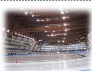
事例:エム・ウェーブ(長野五輪スケート競技施設)国産カラマツの集成材を屋根構造に使用
